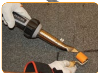
PVC-kermin hitsaus Bitumikermi viimeistelyhitsaus
